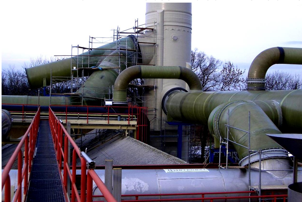
شکل ۱- لوله های کامپوزیتی به نحو گسترده ای در اکثر زیرساخت های صنایع مورد استفاده می باشند و به جهت طراحی محیطی بسیاری از این لوله ها در فضای باز و در معرض مستقیم نور خورشید قرار دارند.
