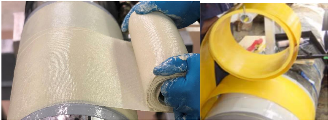
شکل ۴- تعمیرات لوله با استفاده از فناوری پیش آغشته
