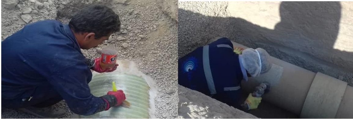
شکل ۳- تعمیرات لوله با استفاده از فناوری لایه گذاری دستی
