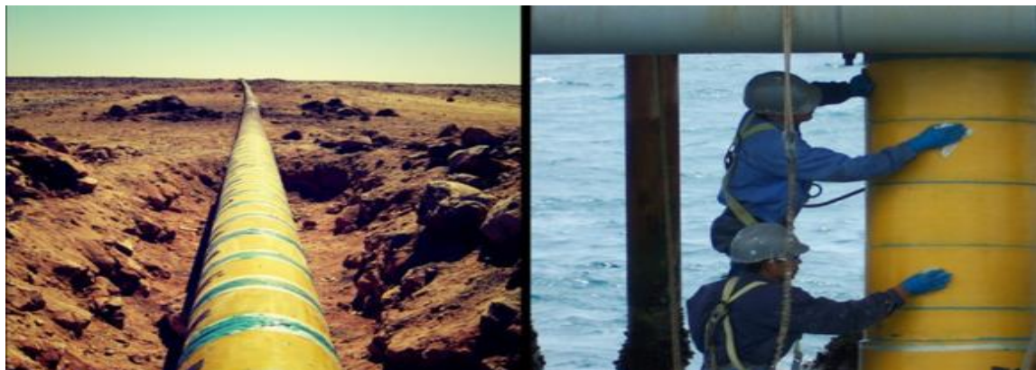
شکل ۲- تعمیرات لوله با استفاده از فناوری قطعات تولید شده در کارخانه
